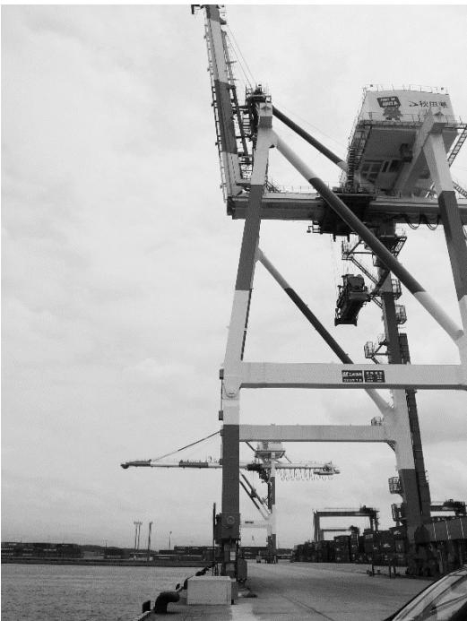
年間5万TEU超の取り扱い実績に迫る秋田港コンテナ・ターミナル
