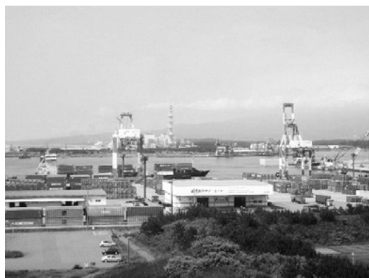
酒田港コンテナターミナル全景（韓国船荷役中） 対岸は酒田共同火力発電所
