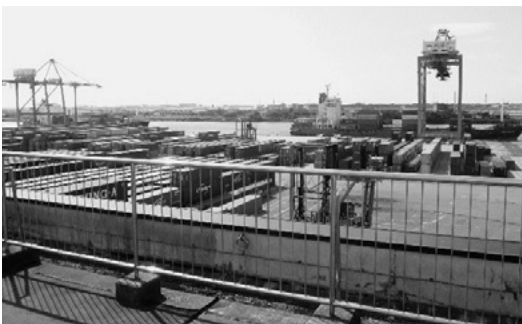
新潟東港のコンテナ・ターミナル。画面右手にもう一つの埠頭と3基目のガントリークレーンで3船同時に荷役可能。
