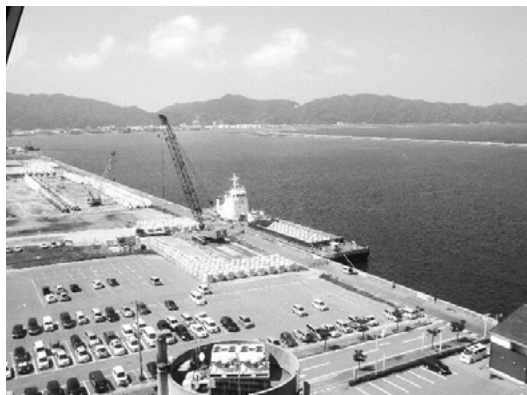
外港竹内南地区で整備が進む新国際フェリーターミナル用地とふ頭(境港夢みなとタワーから臨む)
